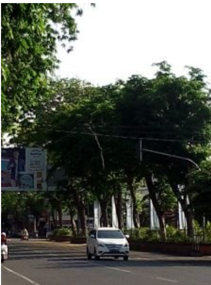
Foto 1 Terlihat ranting dari pohon yang berada di Jalan Soekarno Hatta nyangkut di kabel listrik
