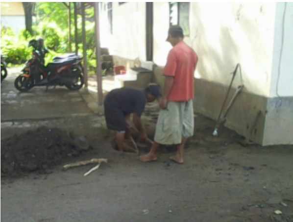
Gambar 1 Pembuatan sumur resapan
