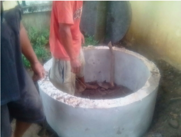
Gambar 2 Proses pengerjaan sumur resapan di Dinas Lingkungan Hidup Kabupaten Ponorogo
