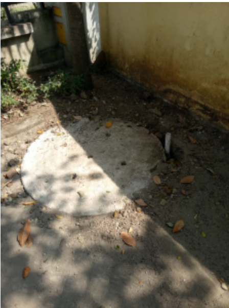
Gambar 2 Proses pengerjaan sumur resapan di Dinas Lingkungan Hidup Kabupaten Ponorogo
